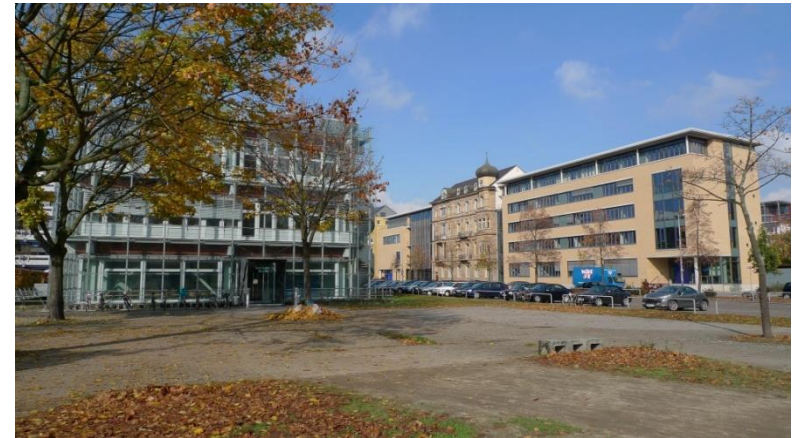
Blick auf die Gebäude A5 und B6
